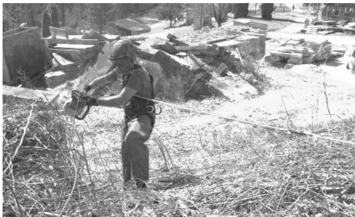
Illustration 89 : assurage avec élingue métallique
