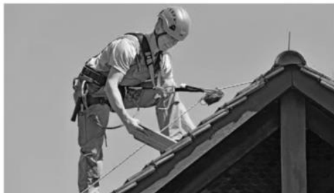
Illustration 34 : antichute mobile sur corde
