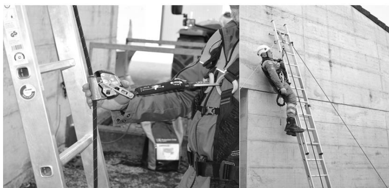
Illustration 94 : chute d'une échelle contre un mur
