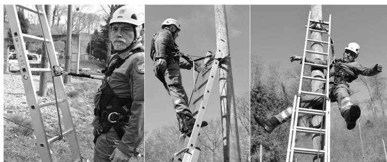
Illustration 92 : chute d'une échelle sur poteau
