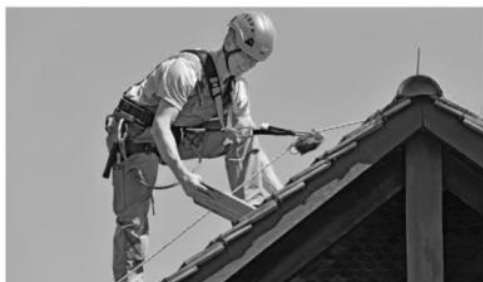
Illustration 34 : antichute mobile sur corde
